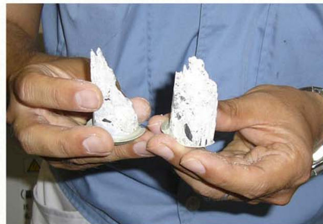
コアの破壊状況
